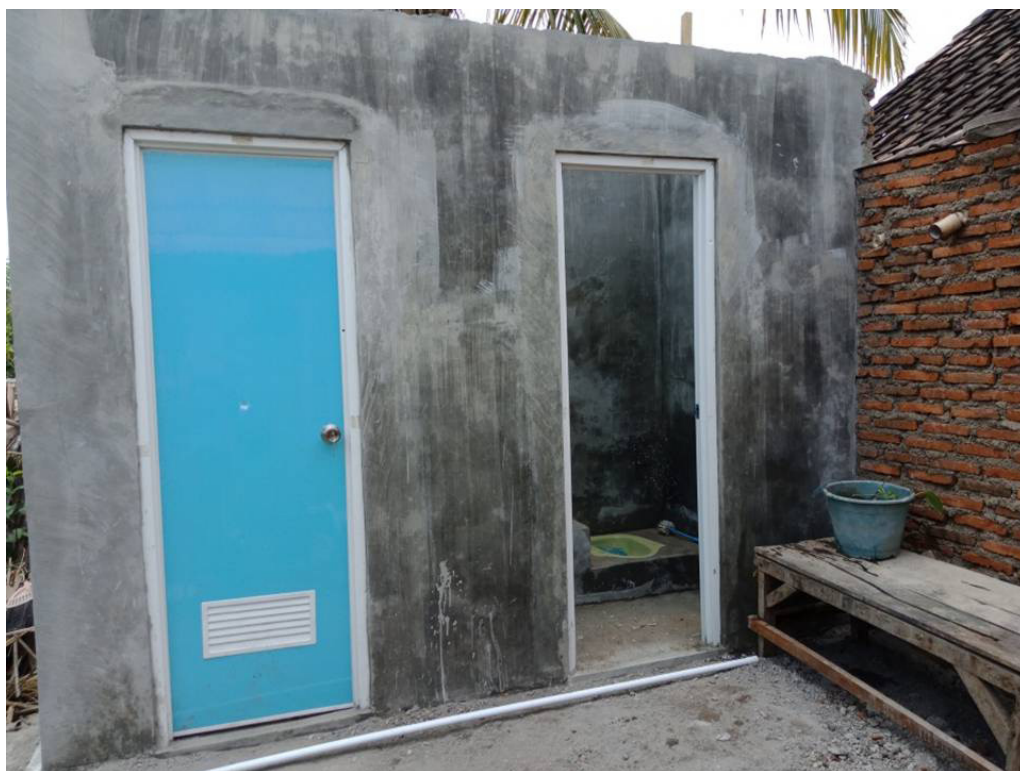
Renovasi jamban rumah penduduk di Probolinggo.
