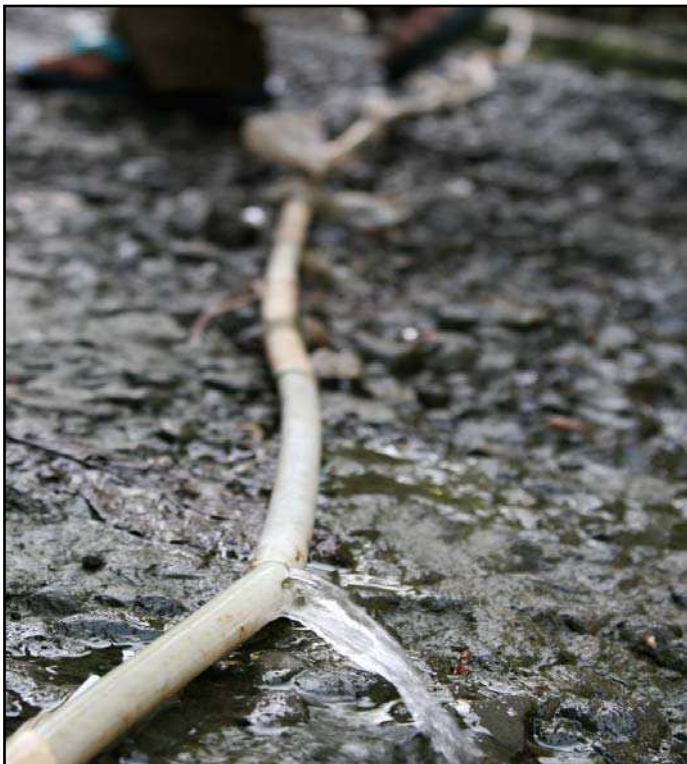
Kebocoran selang air bersih kerap ditemui di jalan-jalan Desa Ciruyung. Warga seperti tidak memperdulikan kondisi ini. Foto: Bowo Leksono.
