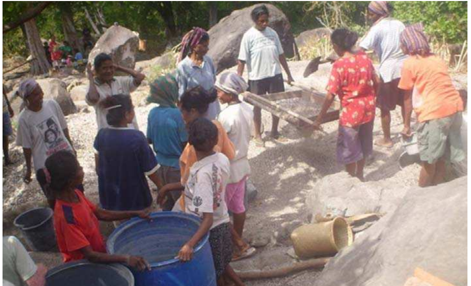
Partisipasi perempuan dalam pembangunan sarana air minum di Desa Mawar. Foto Istimewa
