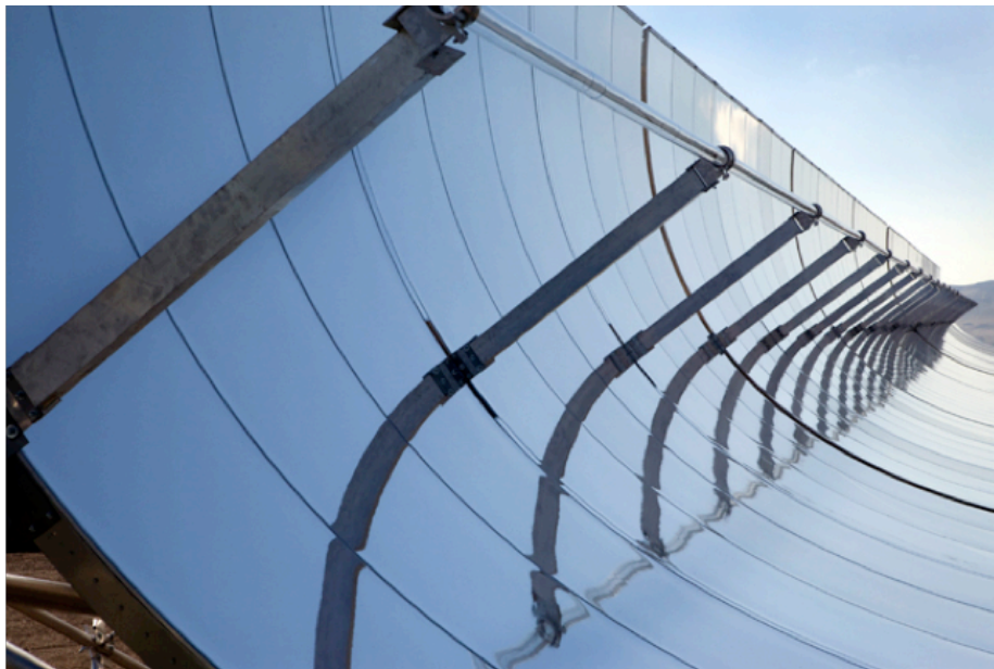
Cermin parabola memanaskan cairan didalam pipa. Sumber: SkyFuel Inc
