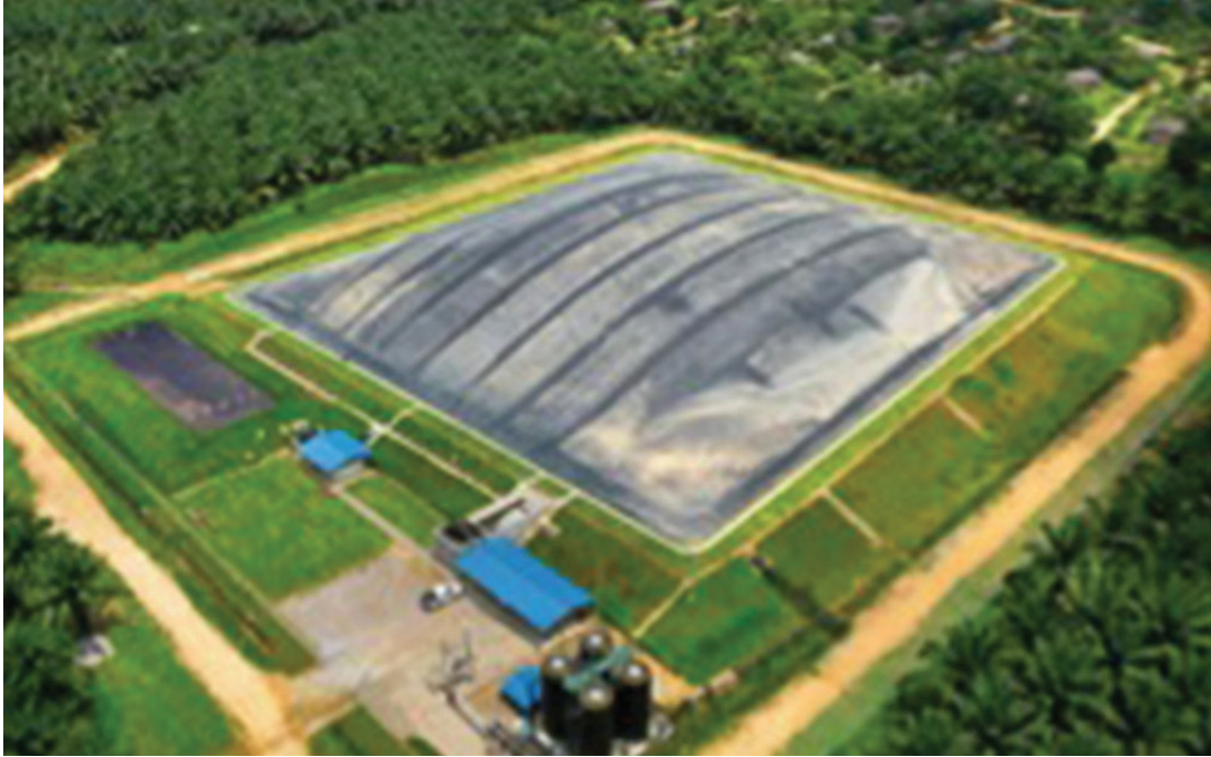
————— GAMBAR 38 ————— DANAU DIGESTER TERTUTUP DAN SISTEM PEMBAKARAN .....
