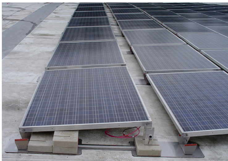
Susunan Sistem Tenaga Surya Fotovoltaik Jenis Rooftop yang menggunakan sistem penyeimbang terpasang lengkap (Non-penetrasi) Sumber: Triad Engineering. Foto: Dan Jordan
