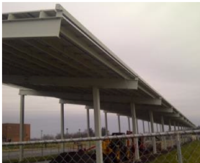
SISTEM KANOPI FOTOVOLTAIK SEPANJANG AREA PARKIR
