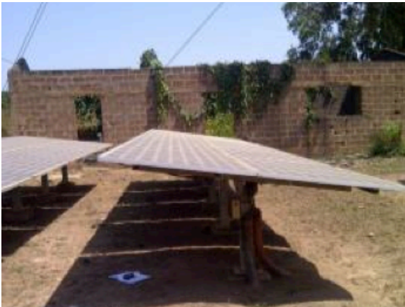
Proyek Tenaga Surya Fotovoltaik di Afrika yang dekat dengan garis Khatulistiwa – sudut kemiringan tinggi. Sumber Foto: Dan Jordan
