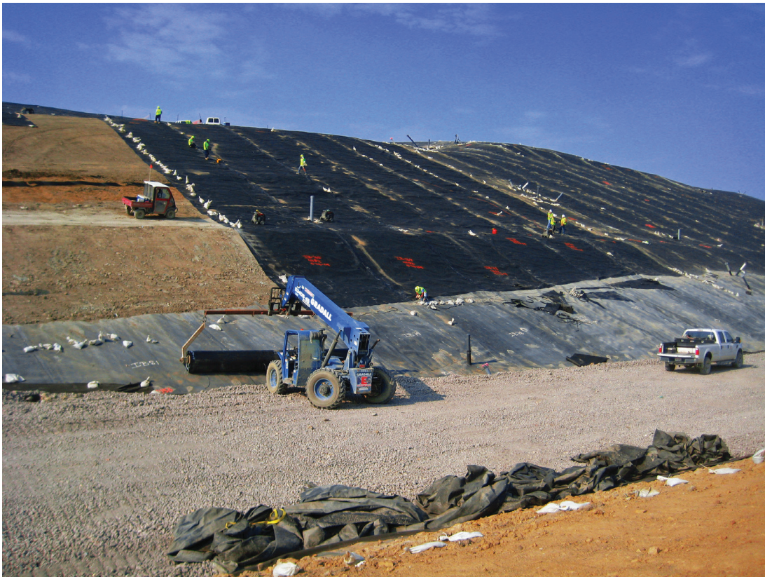
————— GAMBAR 44 ————— PEMANDANGAN SEBUAH LANDFILL YANG MEMPERLUAS SEL DENGAN CARA MEMASANG SELAPUT UNTUK MELINDUNGI TANAH .....
