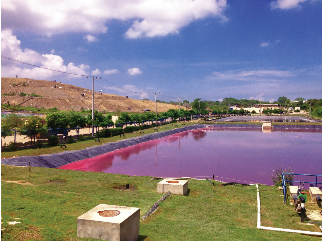
————— GAMBAR 47 ————— CONTOH PENGUMPULAN AIR LINDI SAMPAH DAN KOLAM PENGOLAHAN .....
