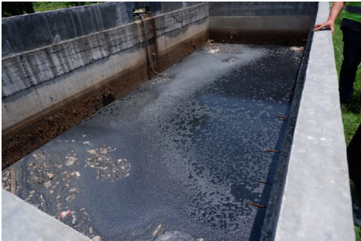
Gambar 23. Kolam penampung limbah cair tanpa proses kimiawi dari proses pengeringan biologis. Foto: WALHI
